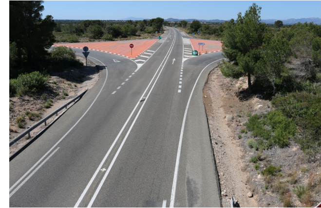
Carretera Nacional N-340
