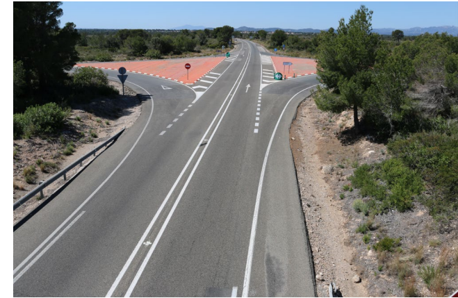
Carretera Nacional N-340
